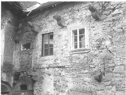
Krakorce ve dvorním traktu jsou zřejmě dovezené z hradu Kynžvart (NPÚ)
